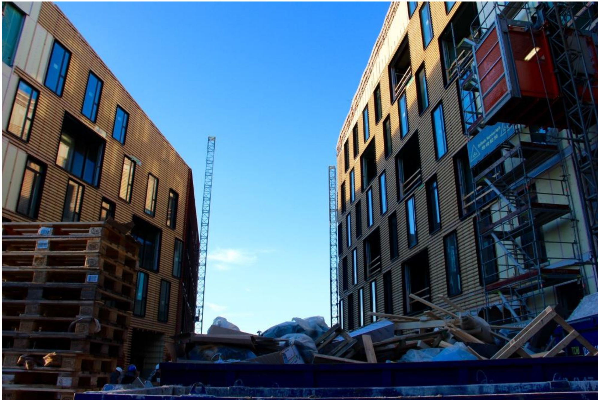
Byggearbejdet var i fuld sving.
